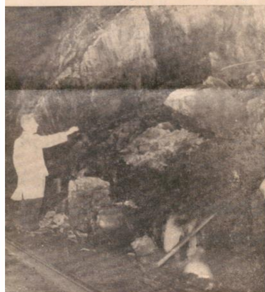
Ljppblock av den storlek som syns på bilden rasade från bergsvägen ner på banvallan och blockerade spåret. Inspicering i berget är med all säkerhet varsaklös.
